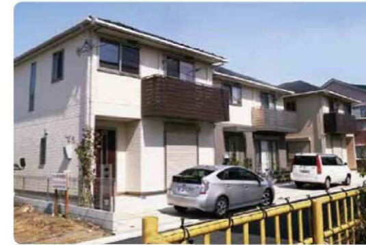
朝霞市 3棟 2016年2月竣工
