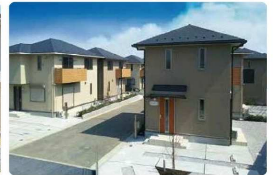
狭山市 12棟 2017年3月竣工
